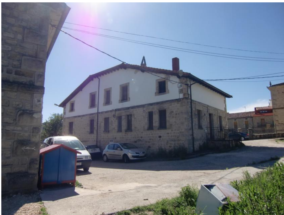
Foto nº 4.- Vista general de la fachada norte y este.
