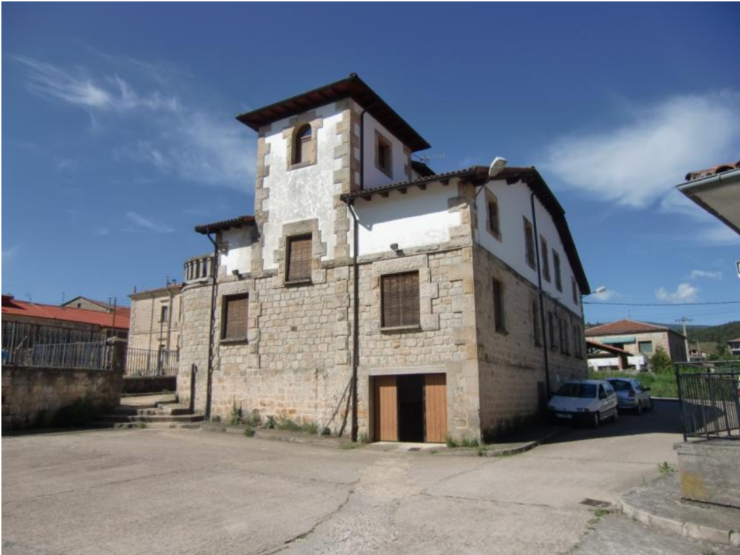
Foto nº 1.- Vista general de la fachada sur.
