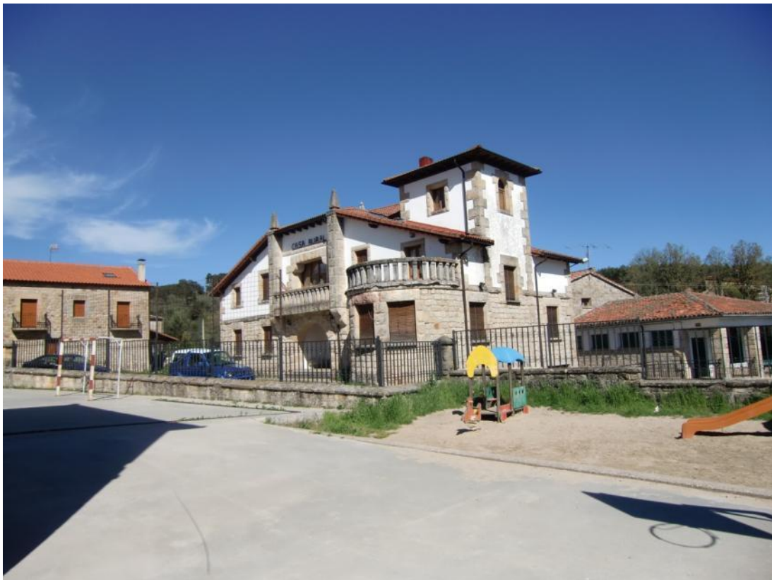
Foto nº 2.- Vista general de la fachada sur y oeste.
