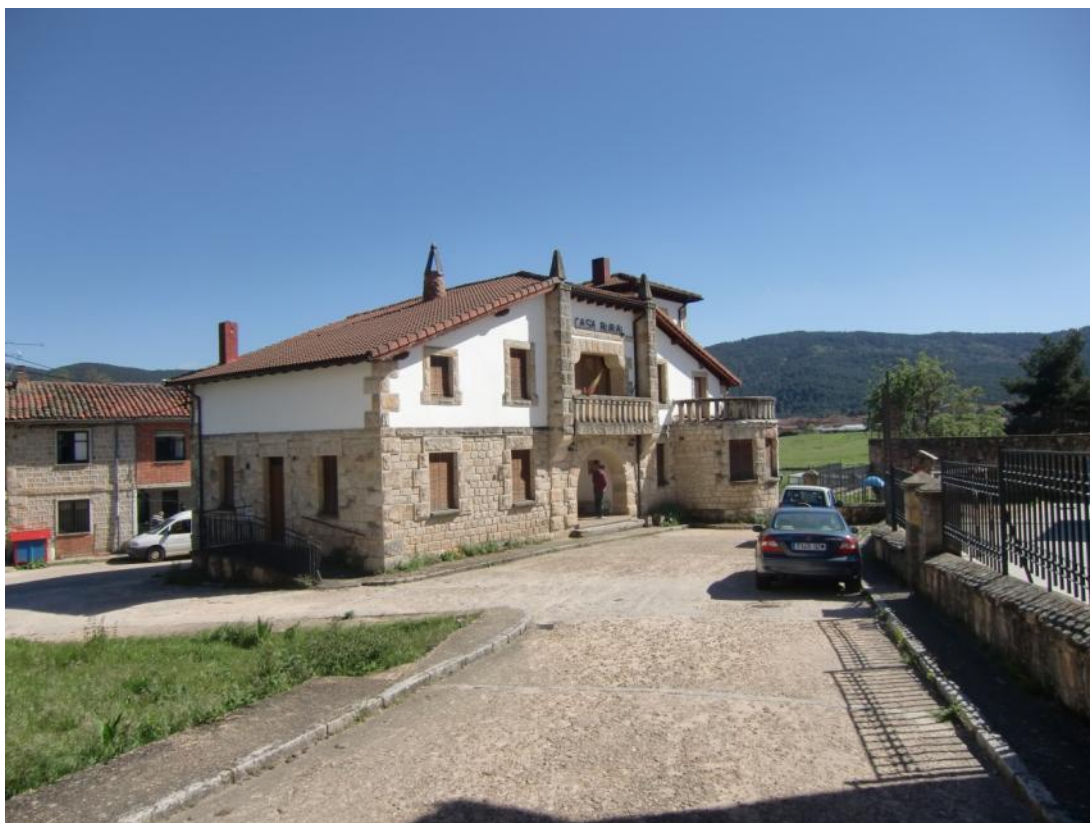
Foto nº 3.- Vista general de la fachada oeste y norte.
